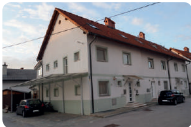
Gostilna je bila podrta; sedaj je zgrajena stanovanjska zgradba.
